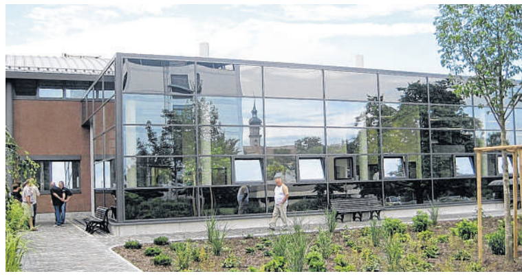
Von außen ein Spiegel Mellrichstadts: Die neue Ausbildungswerkstatt der Firma Reich ist lichtdurchflutet mit Blick ins Grüne.
